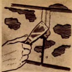
A repedések kittelése
